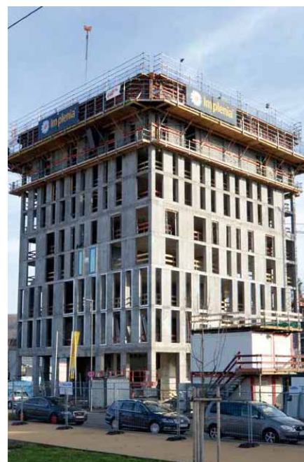
KK2400 og LOGO-storform. Hotel Stadt Lörrach, Fa. Implenia Bau GmbH, Rümmingen.
