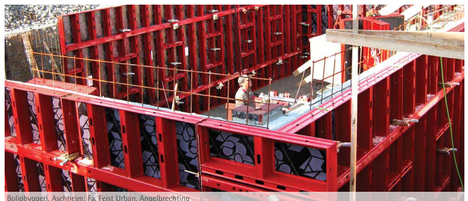
Boligbyggeri, Aschheim; Fa. Feist Urban, Angelbrechting
