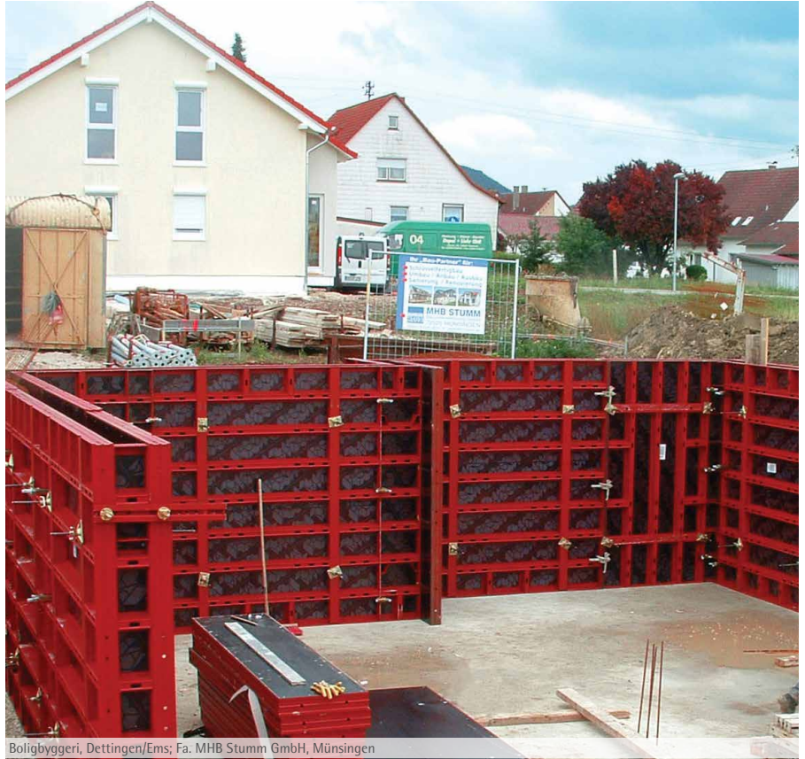
Boligbyggeri, Dettingen/Ems; Fa. MHB Stumm GmbH, Münsingen
