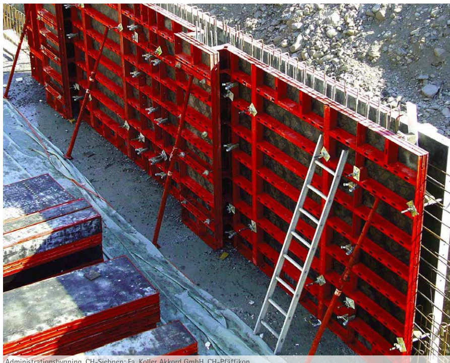
Administrationsbygning, CH-Siebnen; Fa. Koller Akkord GmbH, CH-Pfäffikon.
