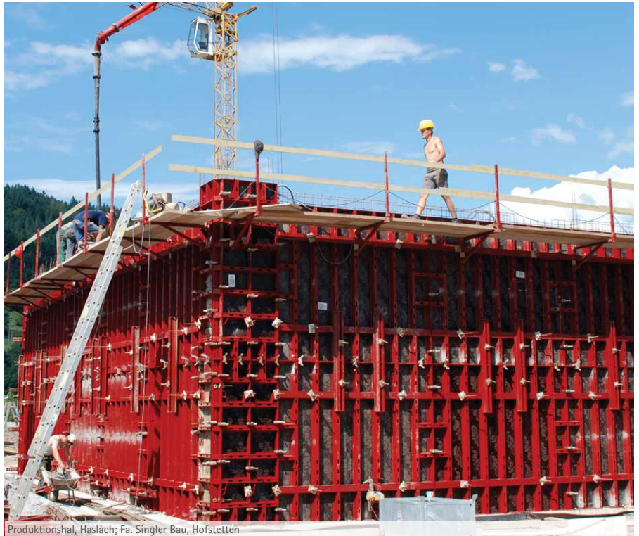
Produktionshal, Haslach; Fa. Singler Bau, Hofstetten
