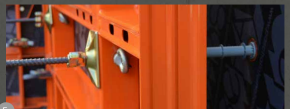
5. Montér kombiplade på spændestav
