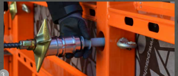
3. Før spændestav, afstandsrør og LOGO.pro muffe gennem den indvendige forskalling, drej spændestaven ind i LOGO.pro insert/gevind
