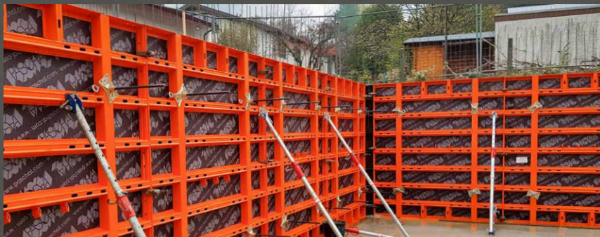
3. Før spændestav, afstandsrør og LOGO.pro muffe gennem den indvendige forskalling, drej spændestaven ind i LOGO.pro insert/gevind
