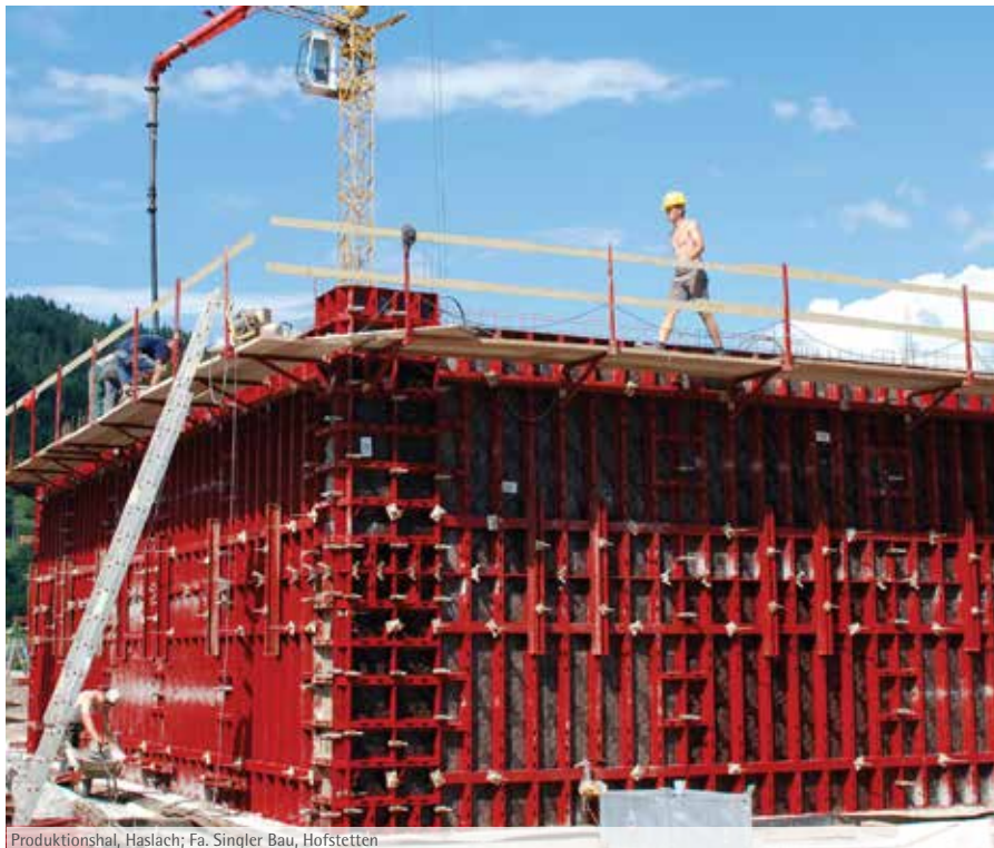
Produktionshal, Haslach; Fa. Singler Bau, Hofstetten
