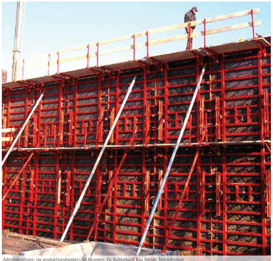
Administrations- og produktionsbyggeri, St. Georgen; Fa. Kaltenbaehi Bau GmbH, Tennenbronn
