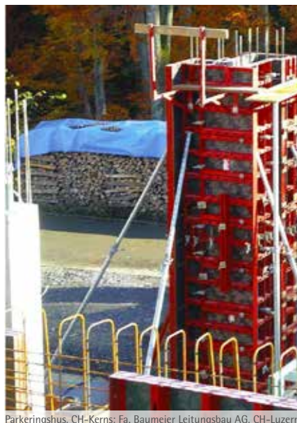
Parkeringshus, CH-Kerns; Fa. Baumcier Leitungsbau AG, CH-Luzern
