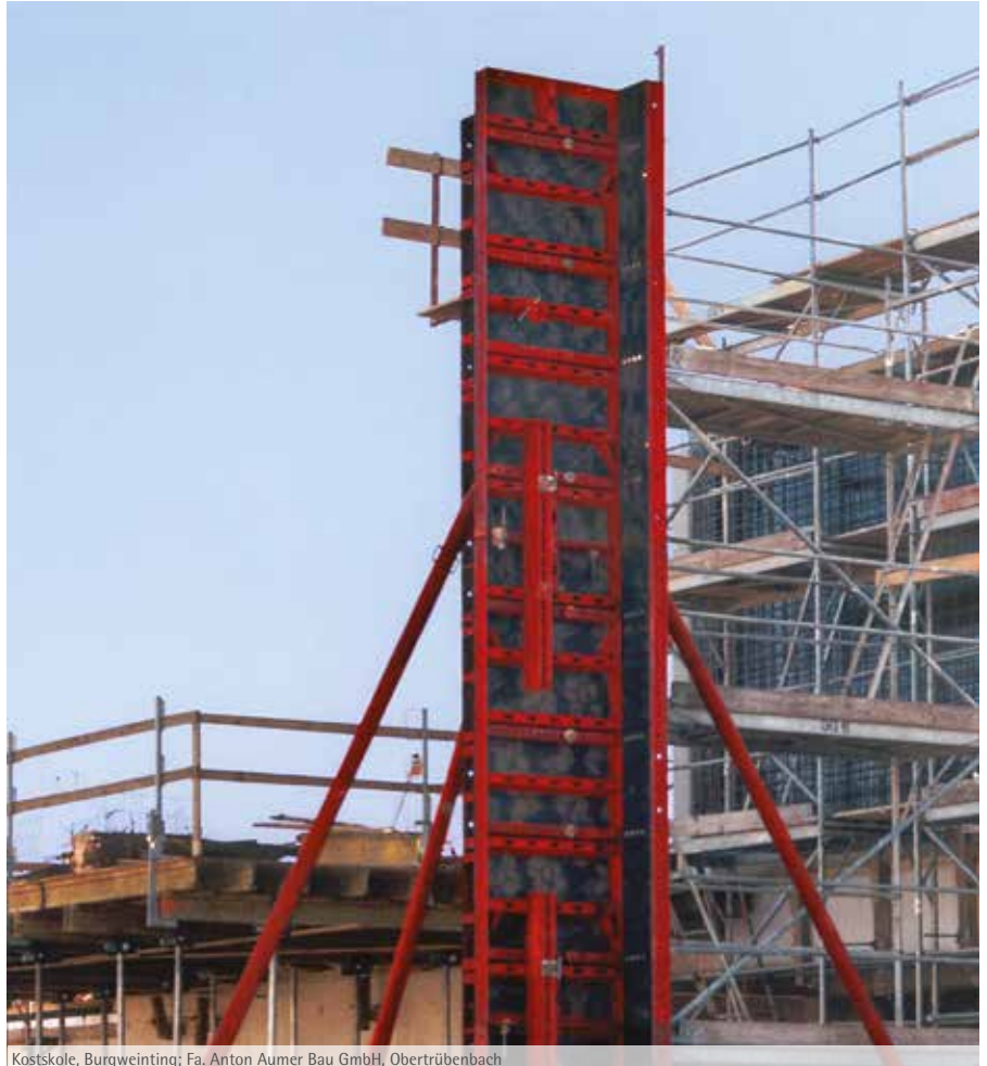
Kostskole, Burgweinting; Fa. Anton Aumer Bau GmbH, Obertrübenbach
