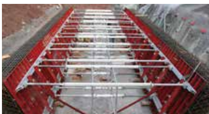
Kanal til regnreservoir, Göttingen; Fa. Tief-Wasser und Erdbau GmbH, Uder
