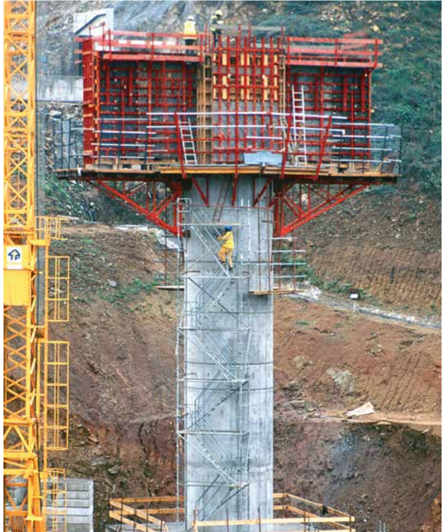
Viaduc du Lalong; EIFFAGE TP Ag, de Clermont-Ferrand, F-Lempdes
