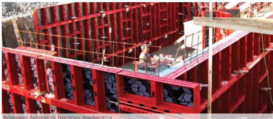
Boligbyggeri, Aschheim; Fa. Feist Urban, Angelbrechting
