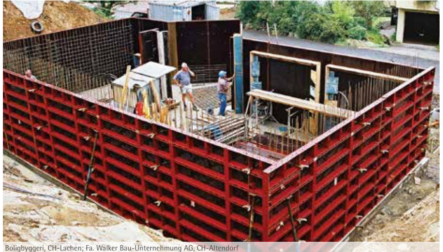
Boligbyggeri, CH-Lachen; Fa. Walker Bau-Unternehmung AG, CH-Altendorf
