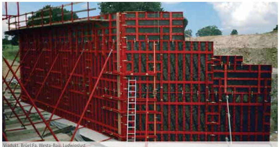
Viadukt, Brühl; Fa. Westa-Bau, Ludwigslust
