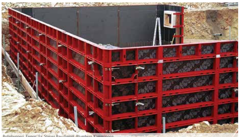
Boligbyggeri, Engen; Fa. Steuer Bau GmbH, Blumberg Kammigen
