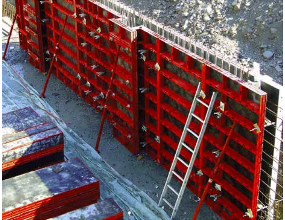
Administrationsbygning, CH-Siebnen; Fa. Koller Akkord GmbH, CH-Pfäffikon.
