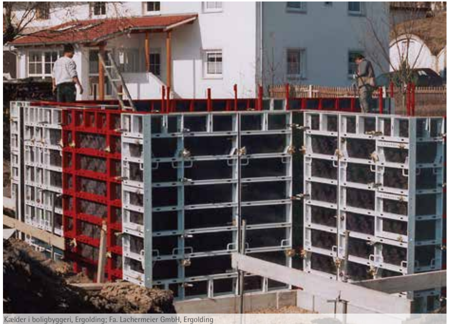
Kælder i boligbyggeri, Ergolding; Fa. Lachermeier GmbH, Ergolding
